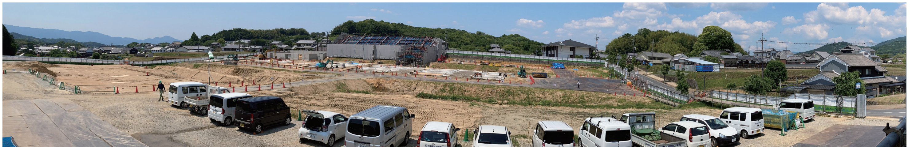
現場事務所から撮影
